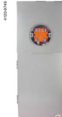
Fig. 9: Cover Mounted After Installation / Reinstalación de la cubierta
